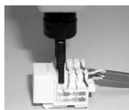
Для вдавливания и обрезки каждого провода используйте ударный инструмент для заделки кабеля типа „110“ или „KRONE“.
