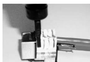
Следуйте наклейке с цветной маркировкой для подсоединения проводов T568A или T568B, отделите немного места в нужном местоположении и вставьте проводную пару попарно в каждый паз. Для вдавливания и обрезки каждого провода используйте ударный инструмент для заделки кабеля типа „110“ или „KRONE“.
